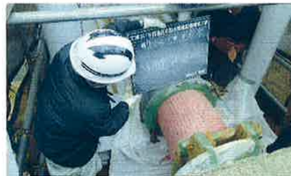
管更生工（接合状況）
