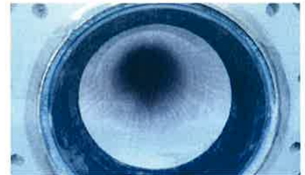
管更生工（完成内部）
