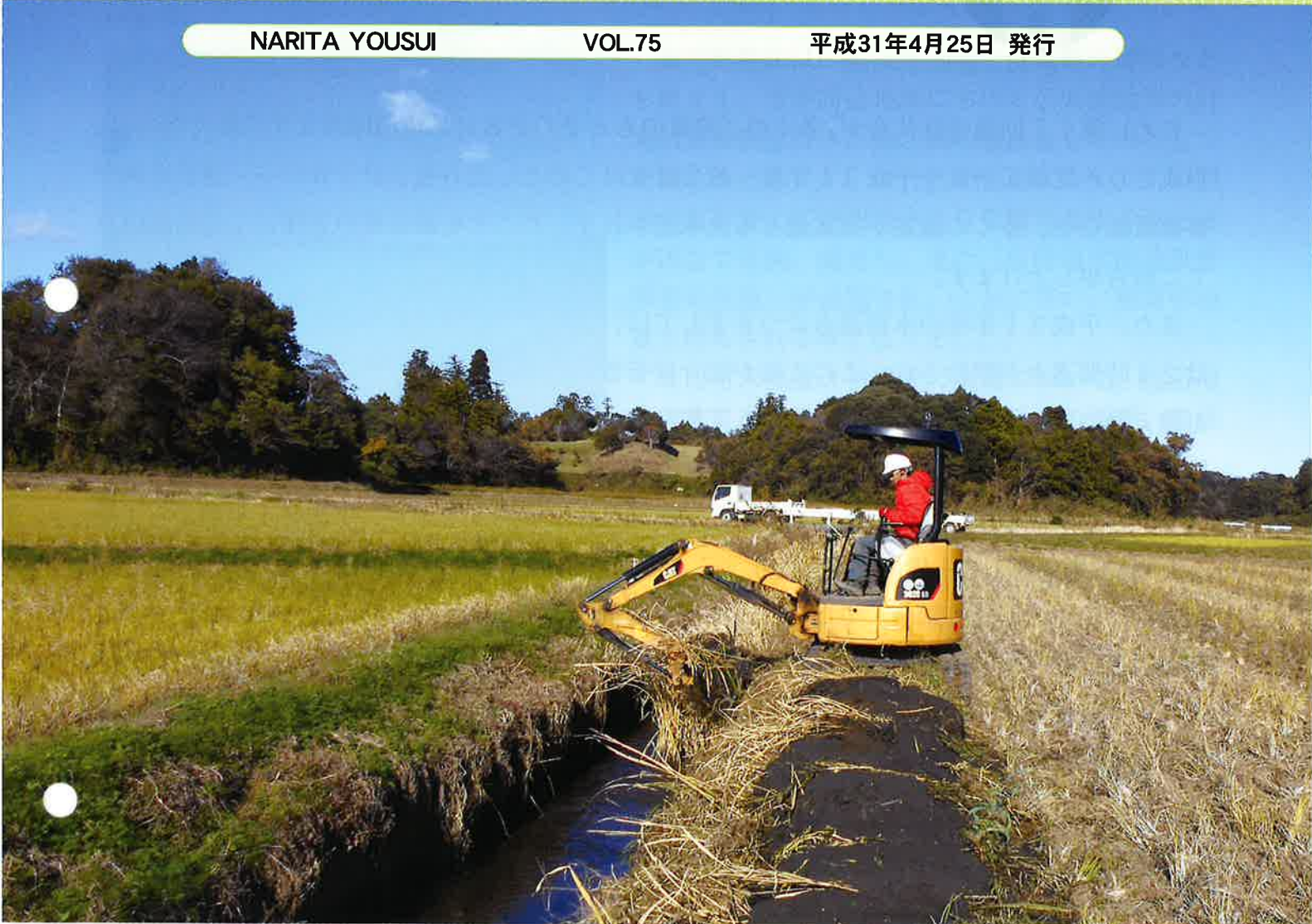
下総管理工区5分区による排水路浚渫作業
