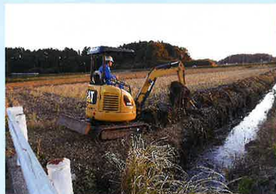
管理工区による排水路浚渫
