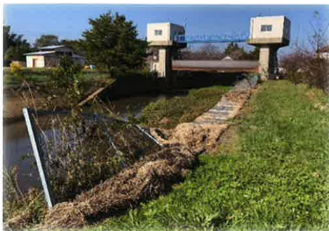
水掛堰フェンス破損
