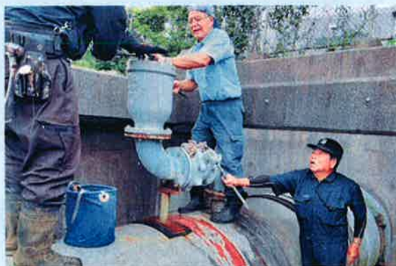
成田用水橋 空気弁分解作業
