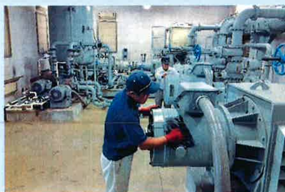
加圧機場内清掃
