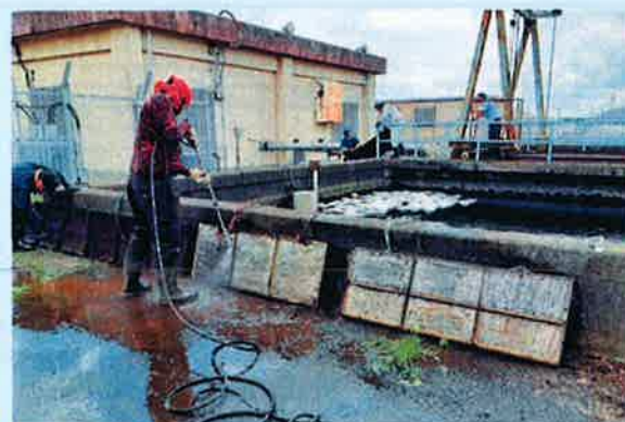
加圧機場フィルター清掃
