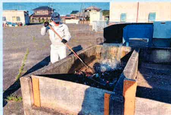
新川揚水機場 除塵作業
