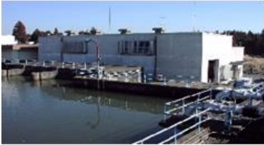
小泉揚水機場
