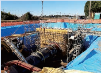
新設制水弁施工状況
