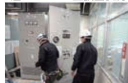
受電した電気をポンプに 届けるための盤設置状況
