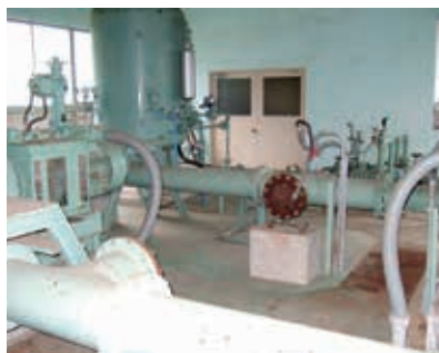
県営小泉揚水機場 全景
