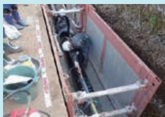
管布設替え状況(DCIPφ350)
