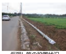
仮廻し管の設置状況
