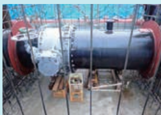
新設制水弁設置状況
