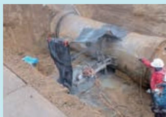
制水弁を新設するために 既設管を一部撤去
