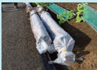
撤去後の石綿管
