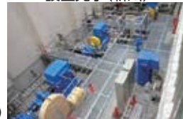
ポンプ点検用の歩廊 設置完了(新川)
