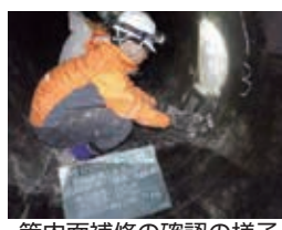
管内面補修の確認の様子
