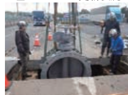
古いバルブの更新状況
