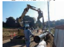
管の吊り込みの様子
