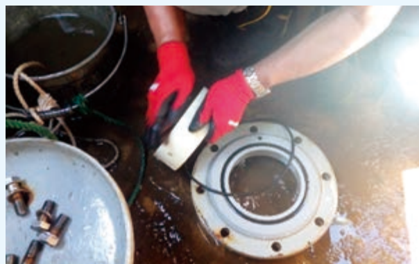
空気弁分解清掃
