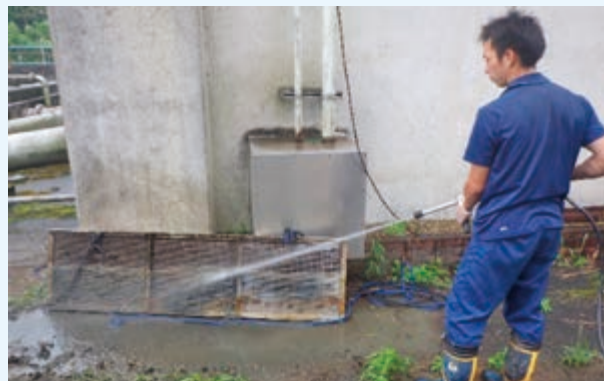
加圧機場フィルター清掃
