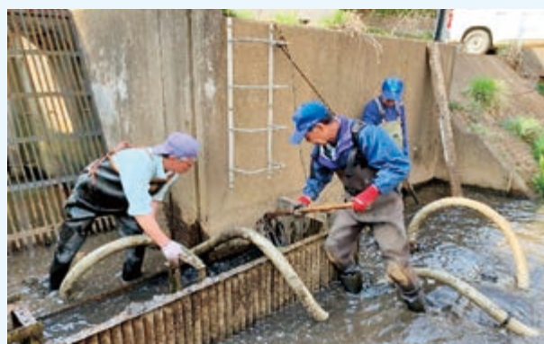
大栄反復機場 排泥作業
