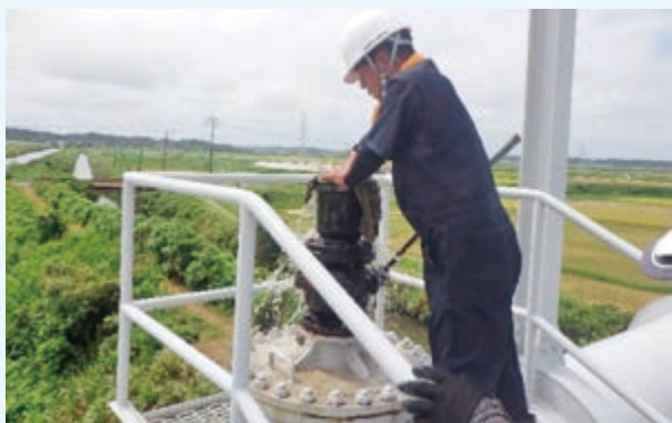
根木名水管橋 空気弁清掃
