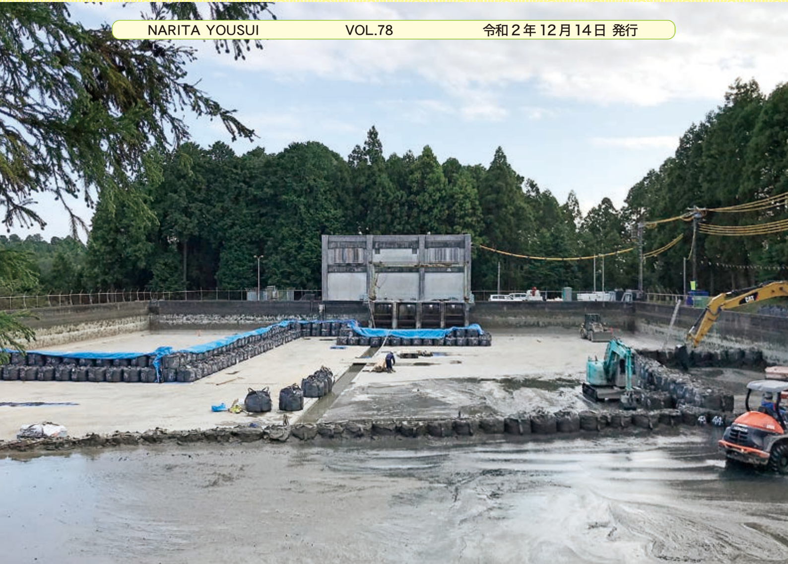
成田用水施設改築事業による、分画化工事中の高田加圧機場
