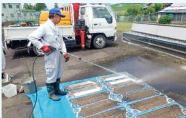
新川機場 冷却パネル清掃(間断通水時)
