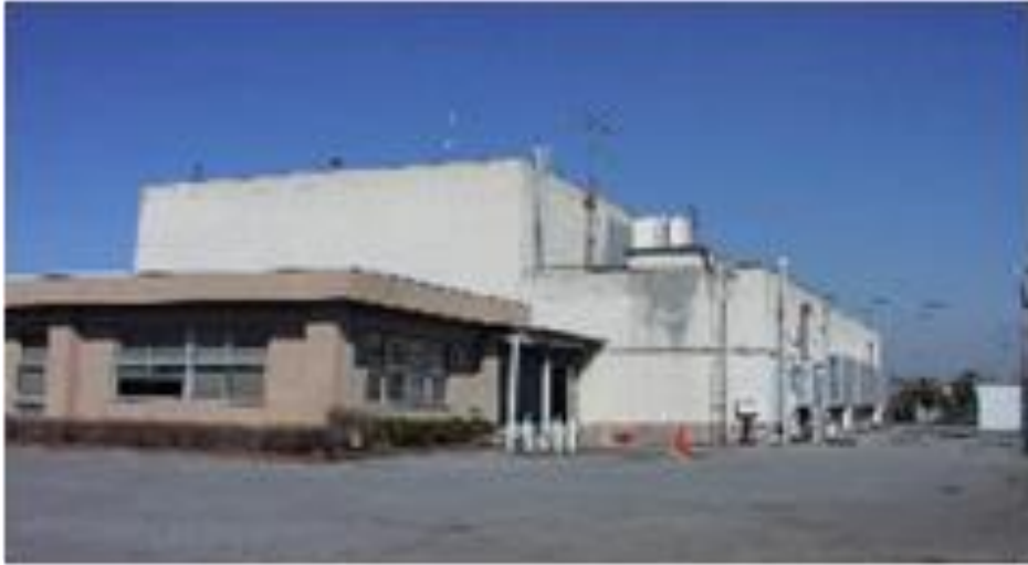
新川揚水機場
