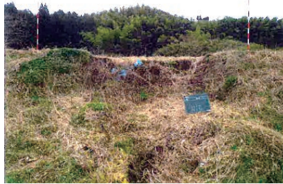
芝山町大台地区 法面補修作業前
