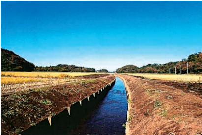
成田市小野地区 幹線水路浚渫作業後
