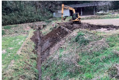
芝山町大台地区 法面補修作業後
