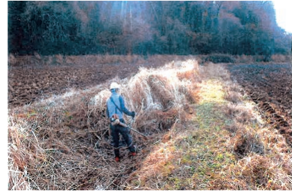
成田市芝地区 排水路浚渫作業中
