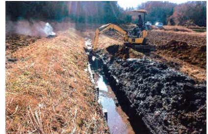
成田市芝地区 排水路浚渫作業中
