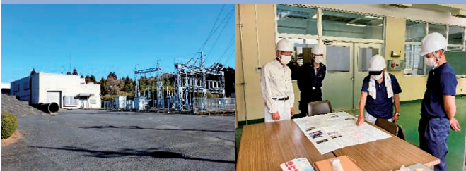
連絡拠点1:小泉揚水機場(成田市土室地先)
