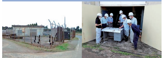
連絡拠点2:芝山加圧機場(多古町林地先)
