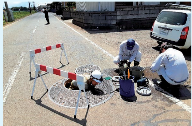
空気弁分解清掃作業
