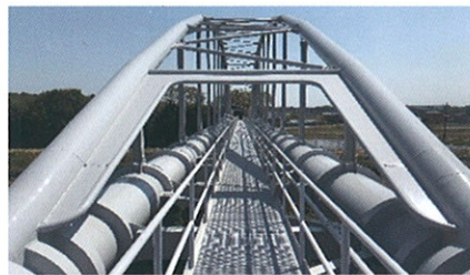
根木名川水管橋塗装塗替後
