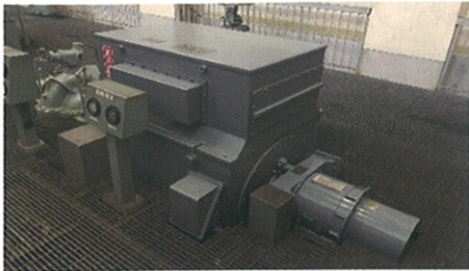
新川揚水機場小ポンプ1号電動機整備後
