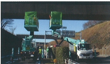
成田用水橋（工事風景）
