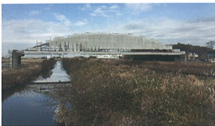
根木名川水管橋塗装塗替工事風景
